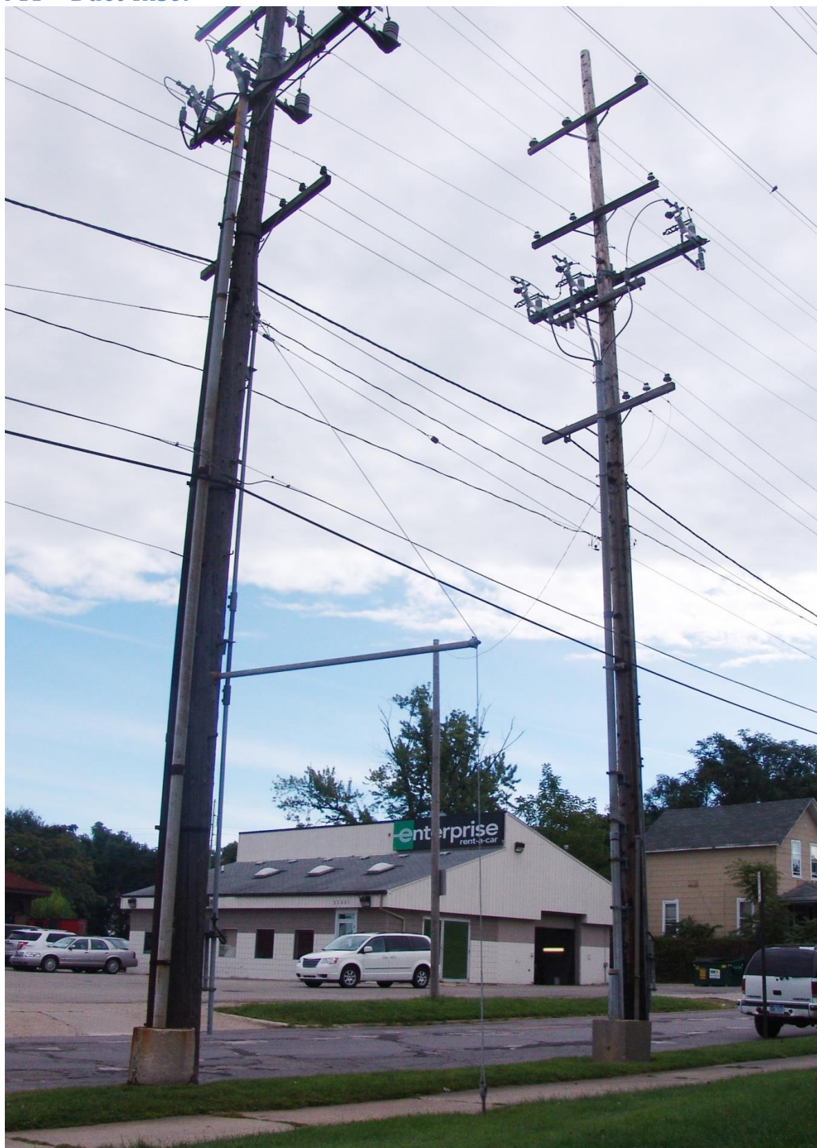
P11 Duct Riser
