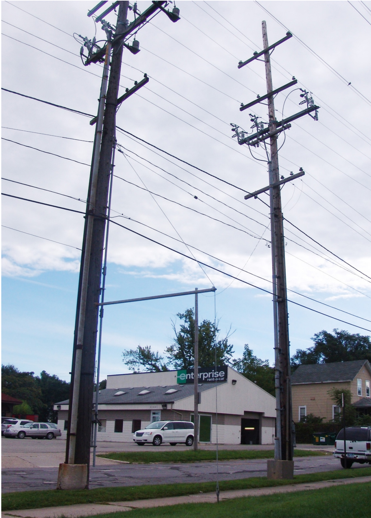
P11 Duct Riser
